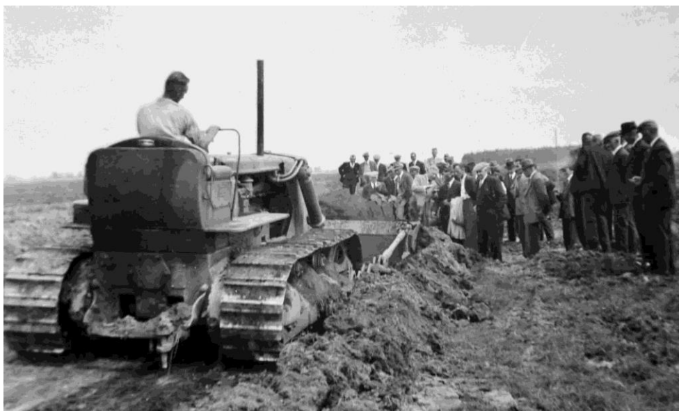
Figuur 58. Het inzetten van een Amerikaanse bulldozer bij het egaliseren van het terrein onder het goedkeurende oog van nieuwsgierigen (collectie: B. Beex).
