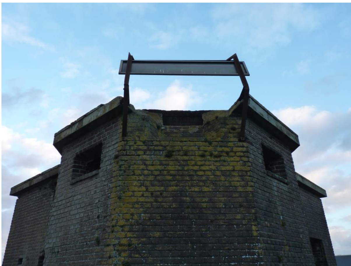
Figuur 41. De door de heemkundekring Hoogeloon gereconstrueerde 'spiegel' op het dak van de bunker (foto: J. Roymans).
